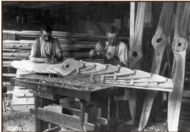
Atelier de construction d'hélices en bois.
